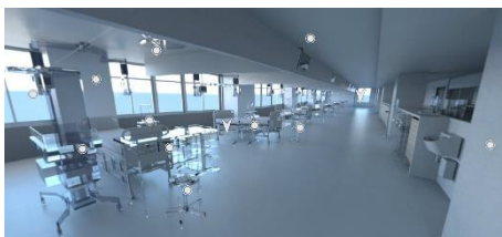
図6 新棟のパノラマシステム
